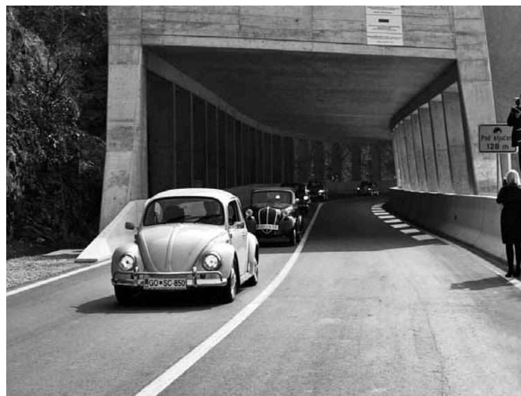
SKOZI GALERIJPOD KLJUČEM , ki varuje mimoidoče pred padajočim kamenjem, so se po uradnem odprtju kot prvi popeljali starodobniki.
