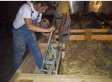
Slika 13: Vgrajevanje toplotne izolacije iz slame v lahke stenske konstrukcije iz lesa; stenski elementi so bili izdelani v delavnici in sestavljeni na gradbišču.
